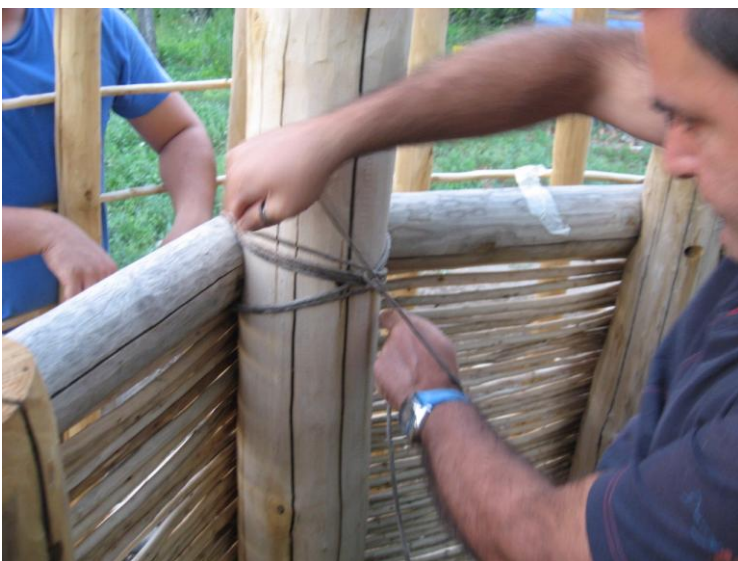
Fig. 4 – Legatura delle pareti di tomagno ai pali portanti con specifiche corde
